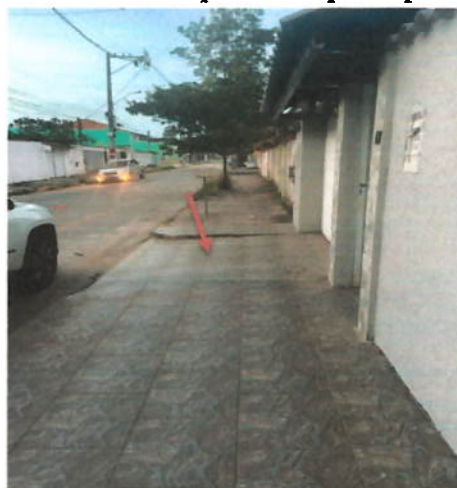
Foto 2 – Rampa acesso principal
