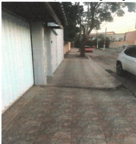
Foto 1 – Calçada acesso principal
