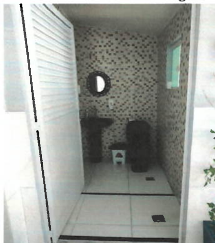
Foto 10 – Sanitário de uso geral
